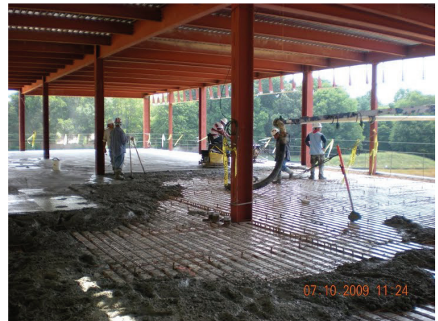
Figure 6 - Slab on Deck Pour
